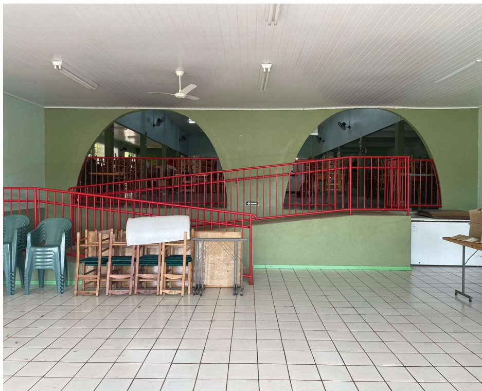
Imagem 02 – Desnível interior (rampa).
